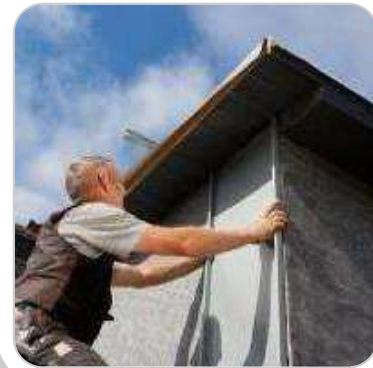
- Sanierung der Dachgauben
