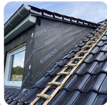
- montierte Gaubendämmung
