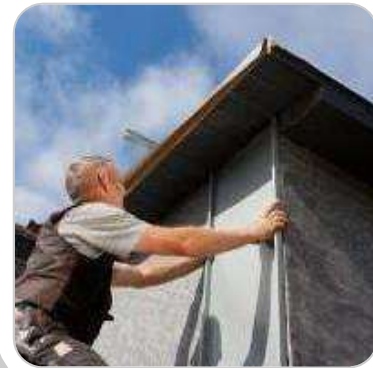
- Sanierung der Dachgauben
