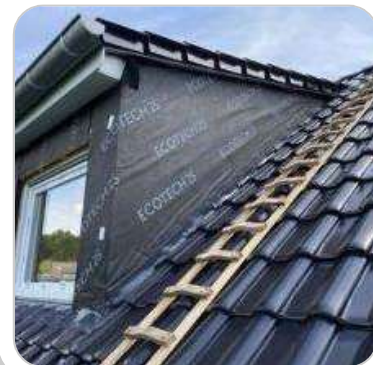
- montierte Gaubendämmung
