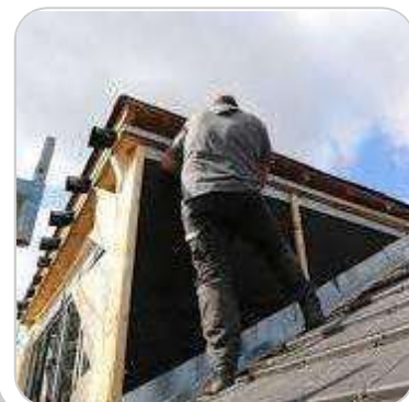
- Montage der Dämmung
