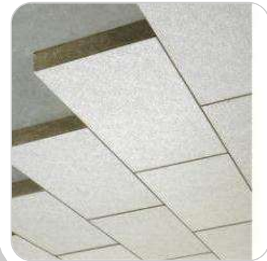
- Darstellung einer Kellerdeckendämmung
