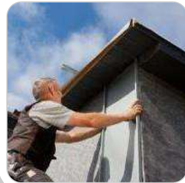
- Sanierung der Dachgauben
