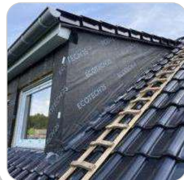
- Montage der Dämmung
